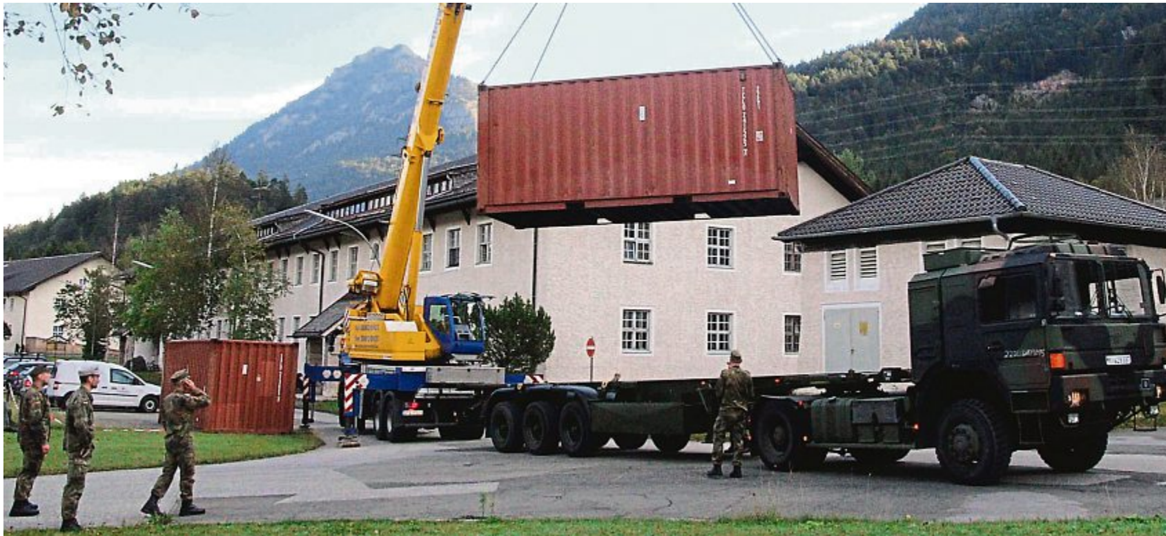
In der Luft: Mit dem Spezialkran wird ein 3,5 Tonnen schwerer Container auf die Zugmaschine gehievt.
